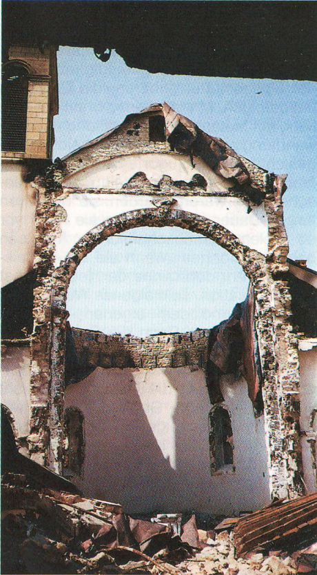
Zerstörte Franziskanerkirche in Mostar
